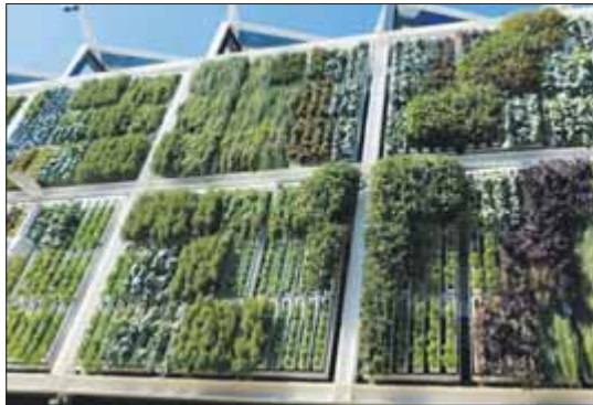
la parete esterna di un capannone
